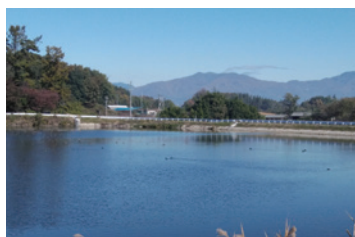
●ため池の水位監視
